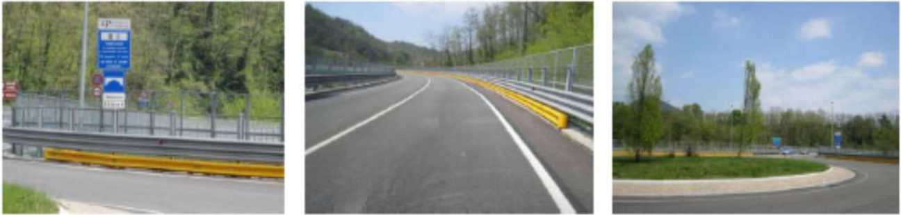
Foto 2.12-2.13-2.14 - Tangenziale Nord-Est di Varese.
